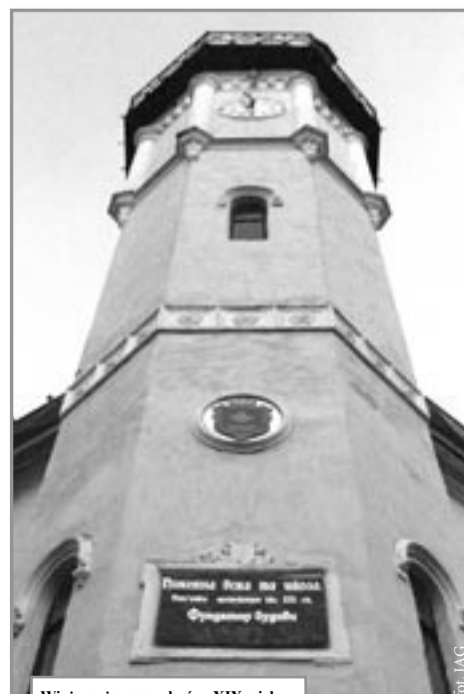
Wieża pożarowa z końca XIX wieku.
