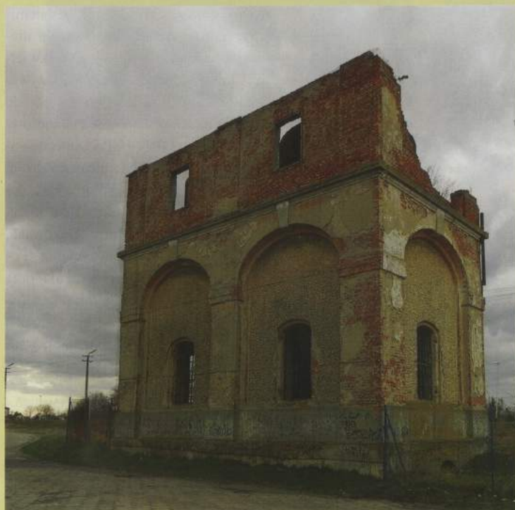
Ruiny wieży ciśnień
