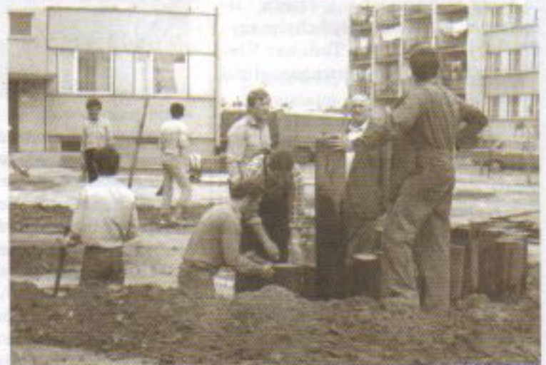
Osiedle Unii Lubelskiej, budowa piaskownicy, 1983r. (czyn)
