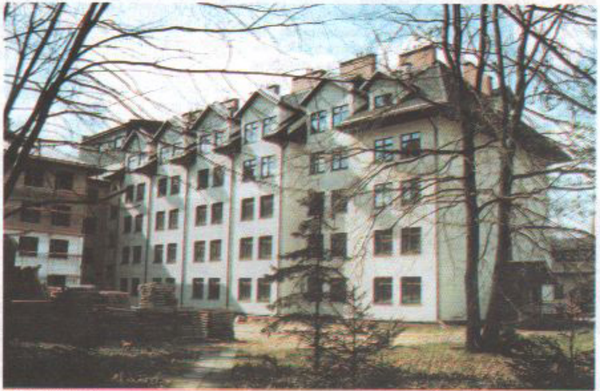
Szpital w budowie
