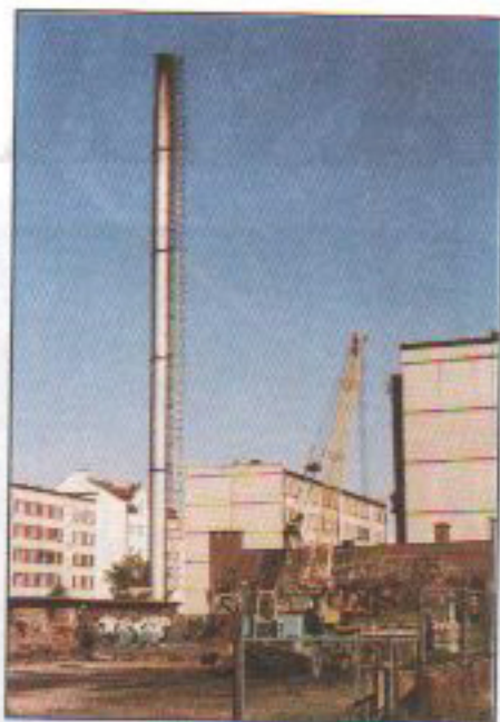
Kotłownia na Osiedlu Jagiellonów
