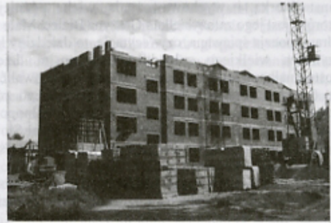
Nowy pawilon szpitala w budowie (fot. 1997r.)
