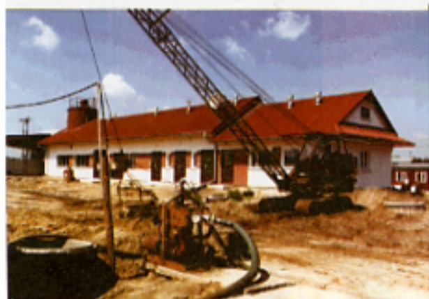
Oczyszczalnia - budynek administracyjny
