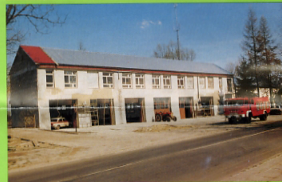
Nowy budynek Straży Pożarnej, ul. Sobieskiego
